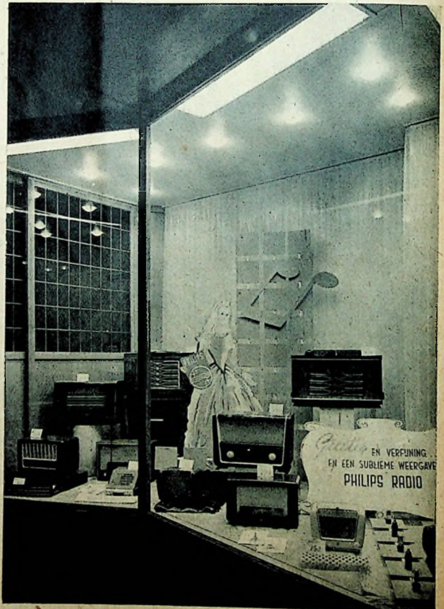
Een etalage uitgerust met TL-buislampen en „comptalux”-lampen. Hierdoor ontstaat een mooie kleur, terwijl de afwerking van de toestellen goed tot haar recht komt.
